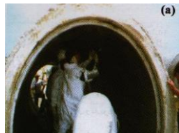
استفاده از FRP در تقویت ستون استفاده از FRP در تقویت لوله
